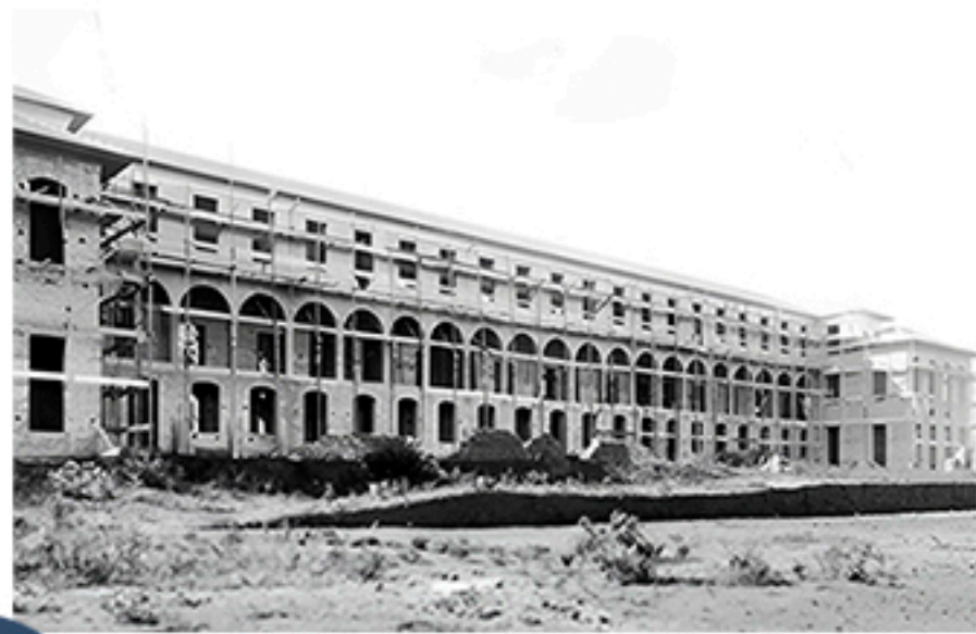
A construção já em estágio bem avançado
